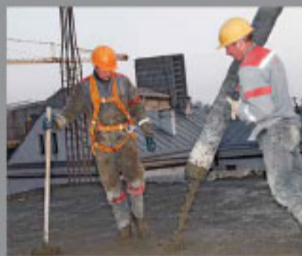
Concreto vertido en sitio
