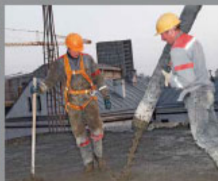
Concreto vertido en sitio
