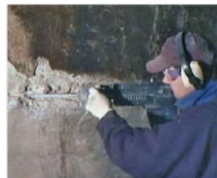
Rehabilitación Patch'n Plug & Megamix
