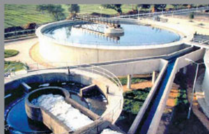
Egipto, Estación de Alcantarillado Shebin El Koum
