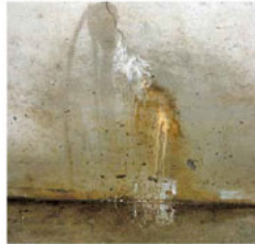
Filtración en juntas
