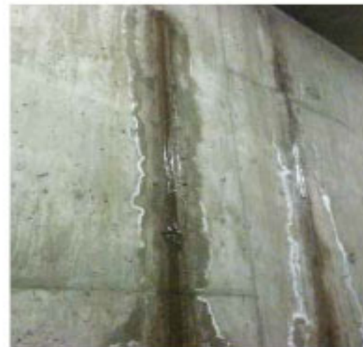
Filtración en juntas
