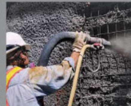
Concreto lanzado
