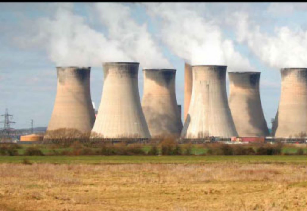
Estación de Energía Cottam, Reino Unido
