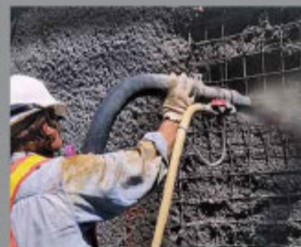
Concreto lanzado
