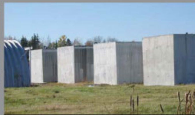
Bunkers de Almacenaje de Desechos Nucleares, Canadá
