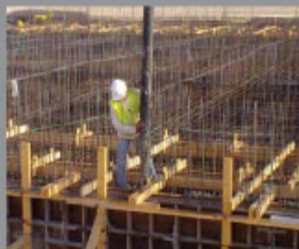
Concreto vertido en sitio
